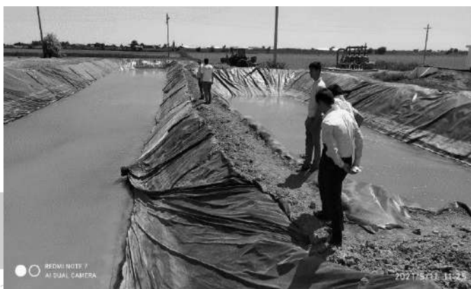
4-расм. «Адизобод Эркин Махмуд» фермер хўжалигидаги томчилатиб суғориш тизимидаги мембранали тиндиргич.
