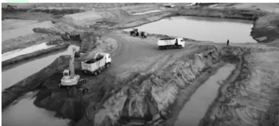
2-rasm. Kanalni loyqalardan tozalash jarayoni.
