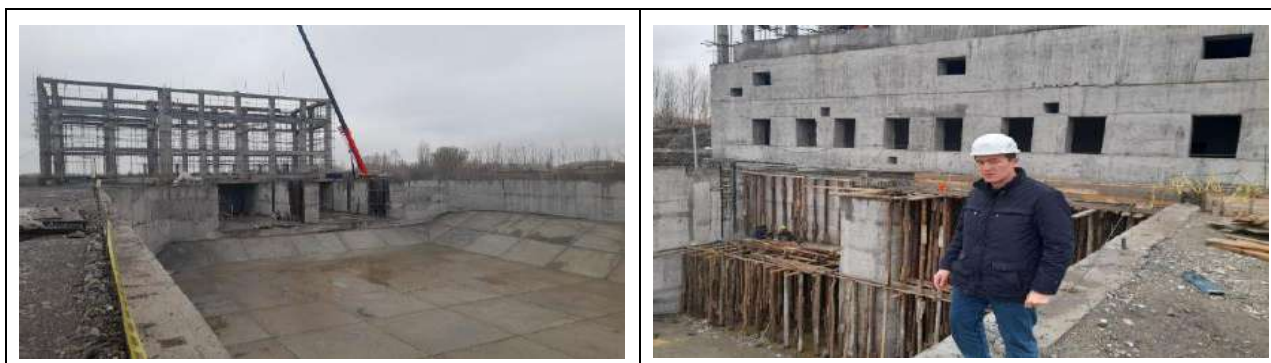
Рис-3. Сооружение нижнего и верхнего бьефа.
