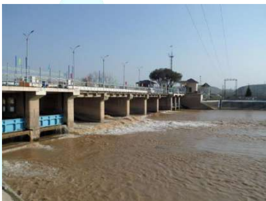
4-расм. Гидроузелнинг сув тақсимлаш қисми
