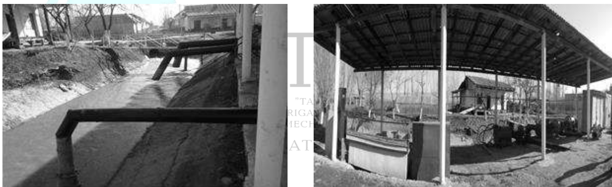
Рис.1. Сооружения насосной станции «Тешиктош-1»: аванкамера и навесное здание станции
