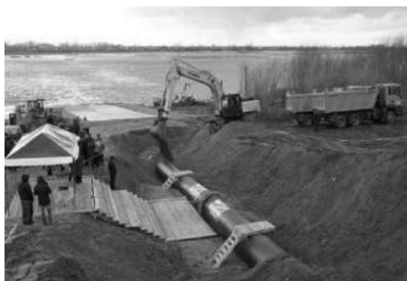
2 – rasm. Dyukerni yer usti sathiga joylashtirish jarayoni.[9]
