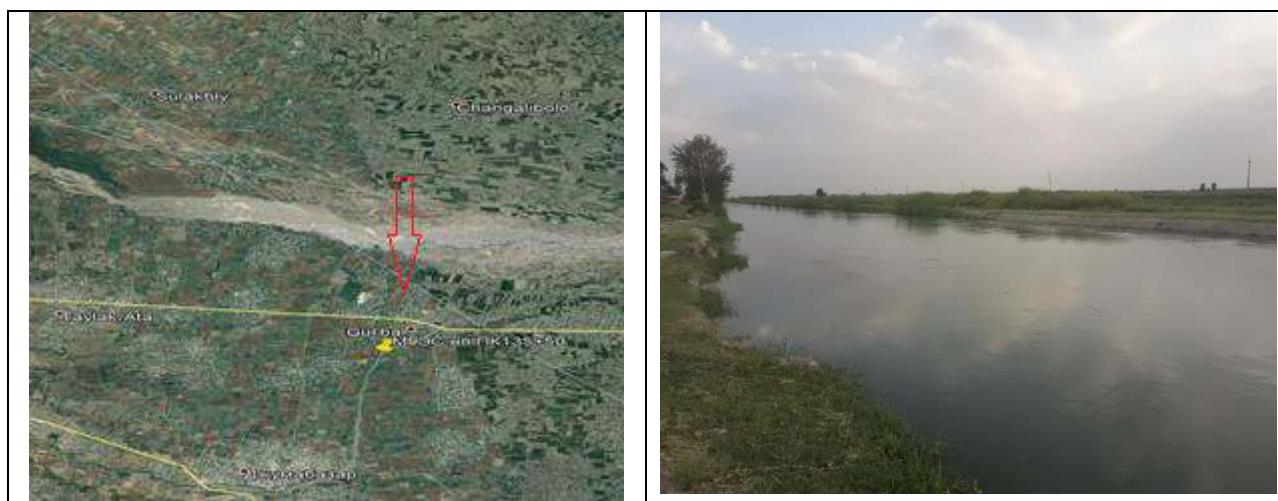
Рис 1. Общий вид участка строительства и верхний бьефы транзитного перепада ПК 130+10.
