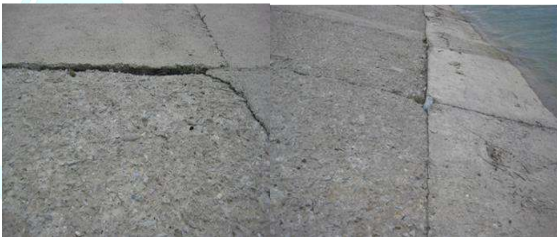
2-расм. Тўғоннинг юқори қияликлари.(Бетон қопламалари кўриниши).
