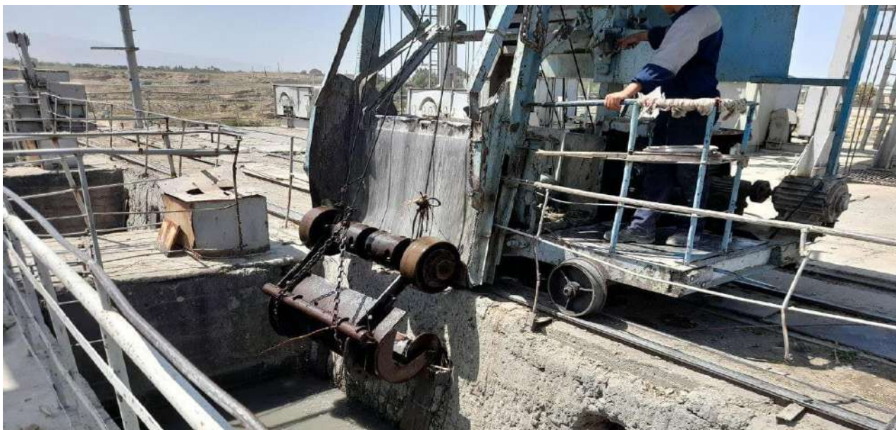
3-расм Ҳишрав ГЭСи да ишлатилётган оқизикларни олиб ташлаш қурилмаси.
