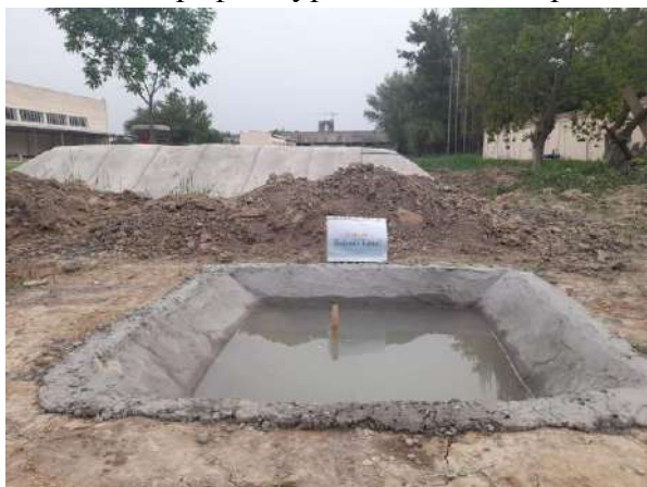
6-расм. Бетонли каналнинг эксперимент
