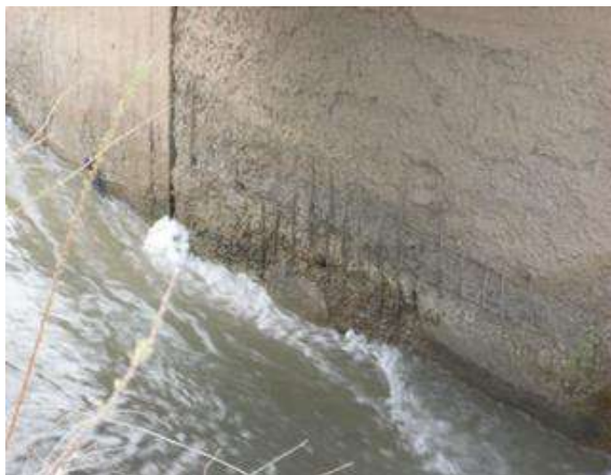
4-расм. Бетон қопламасидаги арматуралар чиқиши.
