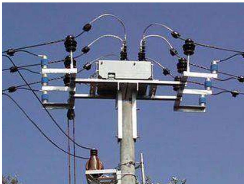
Рис. 6. Реклоузер RVA/TEL "Таврида Электрик"
